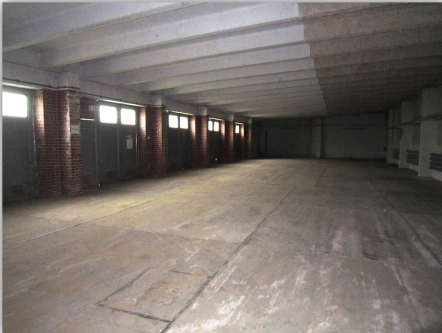
8: LAGER UND GARAGENKOMPLEX INNEN
