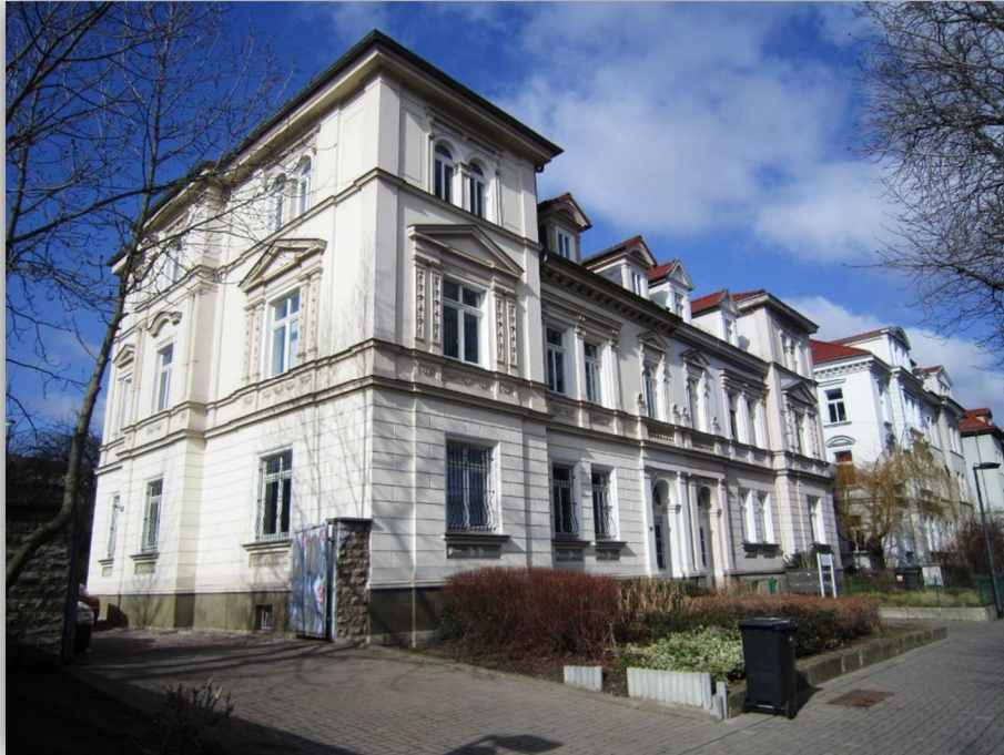
1: GEBÄUDE SÜD-OST ANSICHT
